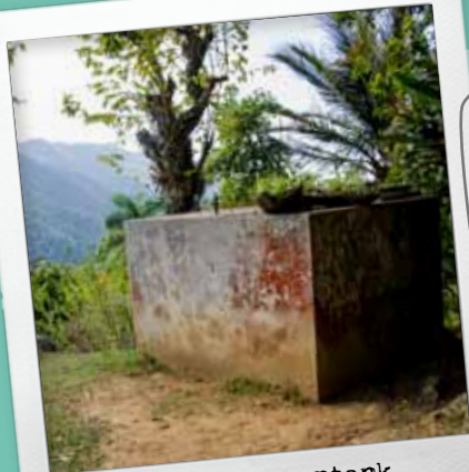
Gemauerter Wassertank (caja de agua) in der Sierra Maestra,...
